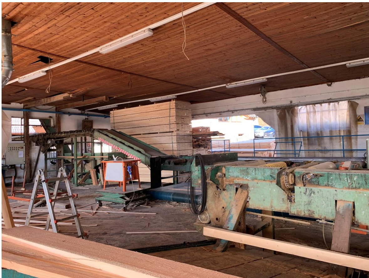
Interno capannone ex segheria
