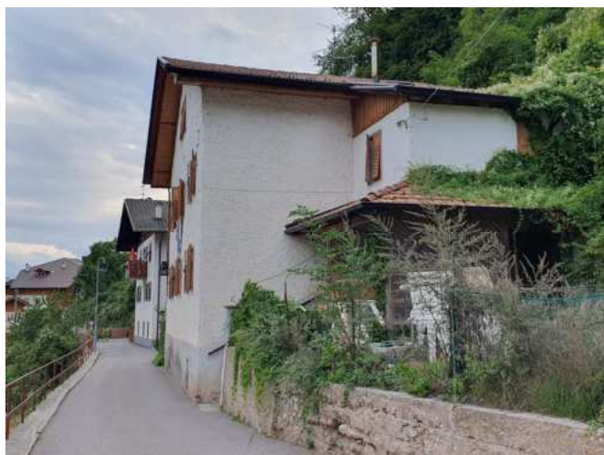
Est da Via San Rocco
