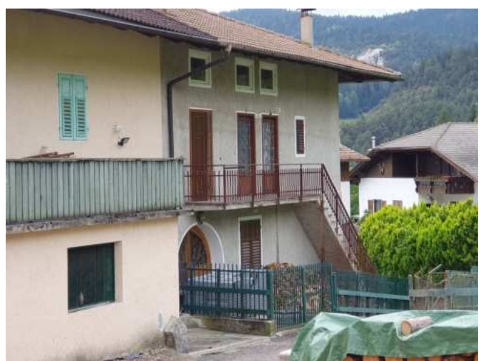
Est da Via San Rocco
