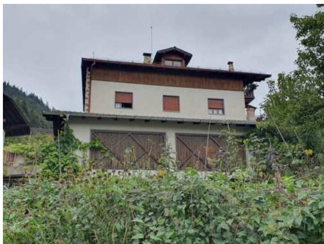
Est da Via San Rocco
