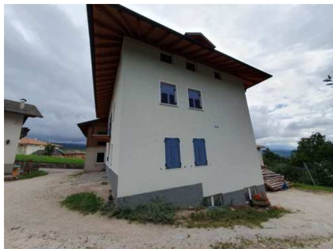
Est da Via San Rocco
