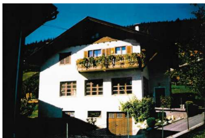
Est da Via San Rocco
