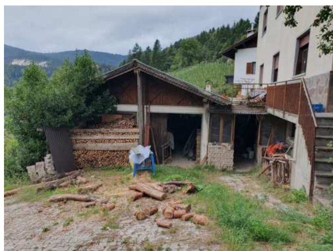
Est da Via San Rocco
