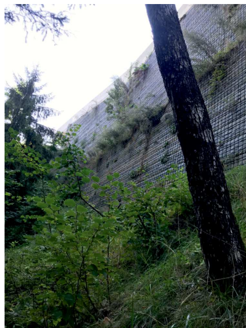
Terra armata posta lungo il fianco sx della vallecola in esame.
